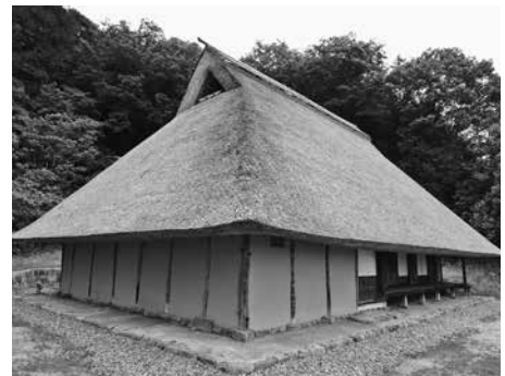
重要文化財 旛山家住宅 保存修理工事
