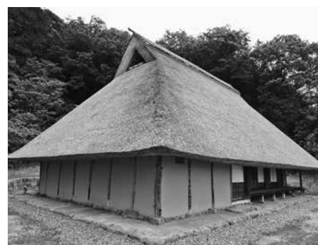
重要文化財 旆山家住宅 保存修理工事
