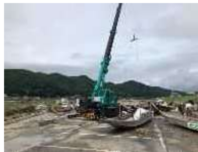
災害復旧作業の様子
