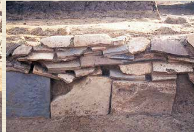
塔基壇北辺と瓦積み
