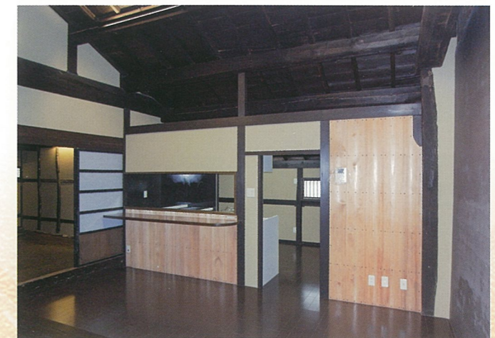
竣工した主屋内部 土間に仮設した台所設備
