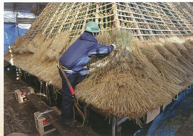
修理工事中の主屋 茅葺きを施工しているところ
