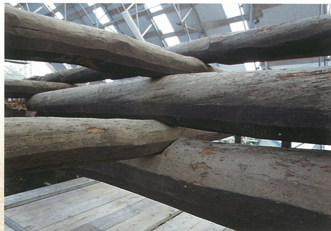
修理工事中の主屋 土間上の梁組み
