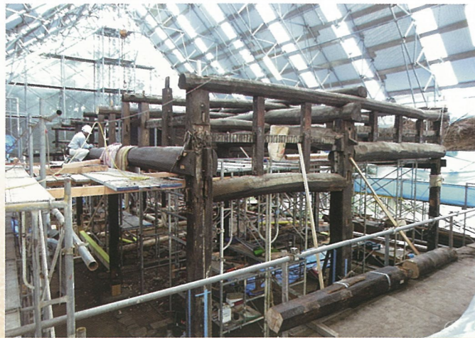
修理工事中の主屋 軸部材を補修しているところ
