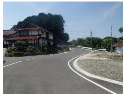
道路拡幅（市道穴笠畠敷線）
