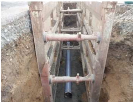
開削管渠布設工事（三次町）
