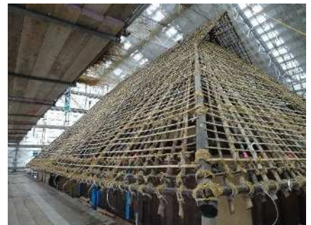
修理中の様子（幡山家住宅）
