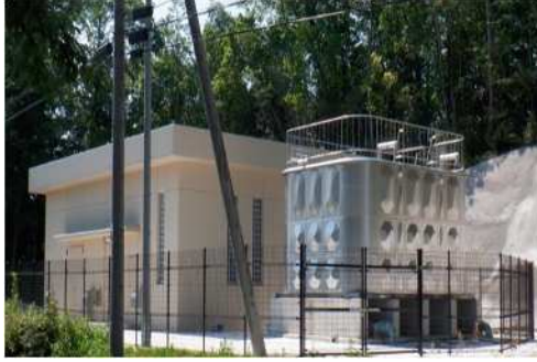
ポンプ所の整備（和知ポンプ所）
