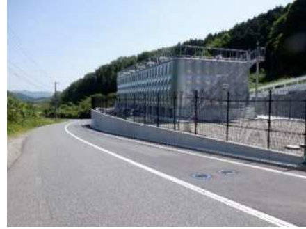
配水池の整備（八次配水池）
