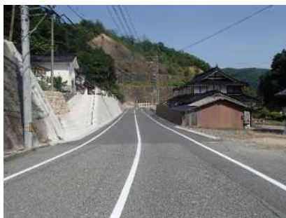
道路拡幅（市道三次山家線）
