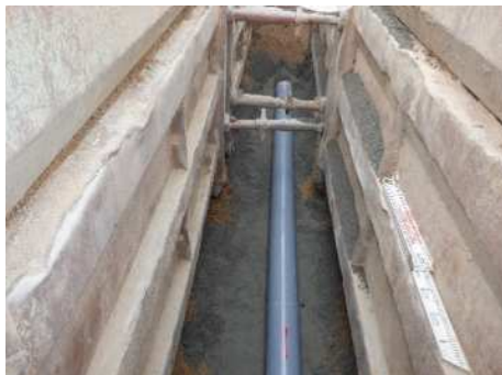
開削工法による管渠布設工事（三次町）
