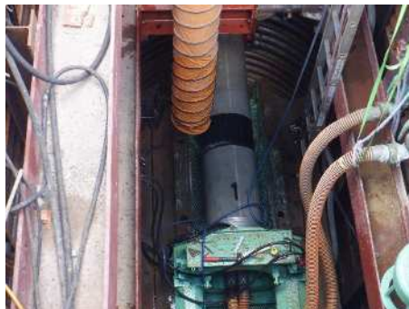
推進工法による管渠布設工事（畠敷町）
