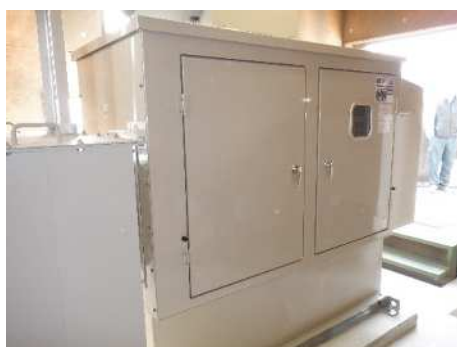
吉舎第1浄水場自家用発電装置の更新
