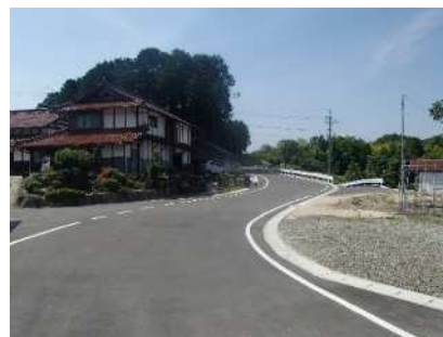
道路拡幅（市道穴笠畠敷線）
