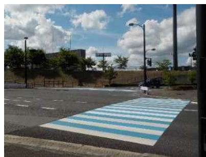
カラー舗装による横断歩道の明確化 （市道西酒屋仁賀線）
