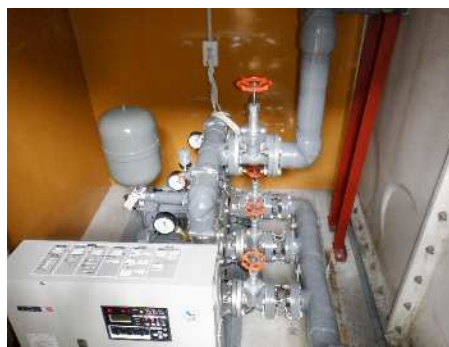
堂山ポンプ所の給水ポンプの更新（南畑敷町）
