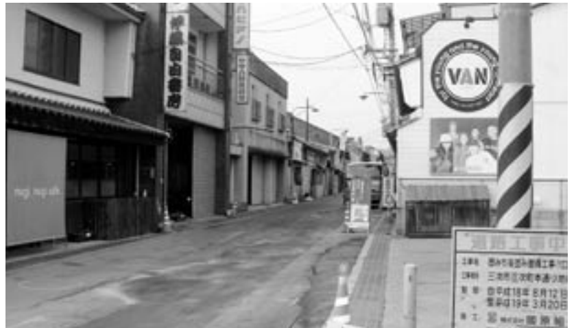
歴みち街並み整備工事(三次町本通り)
