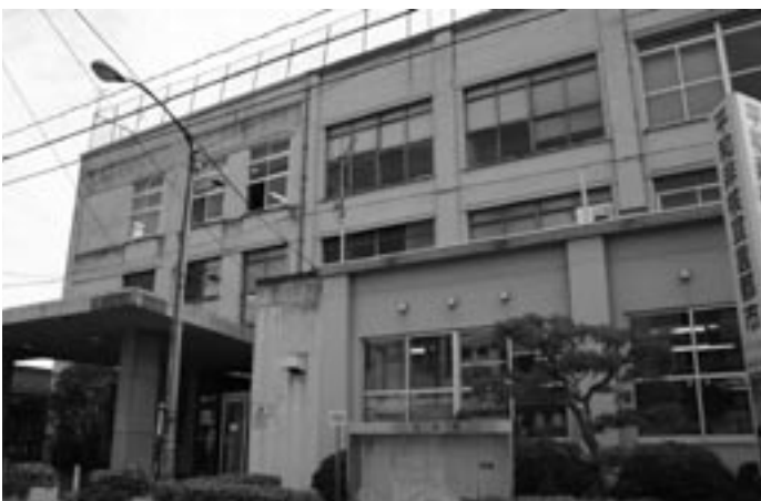
三次市役所本館
