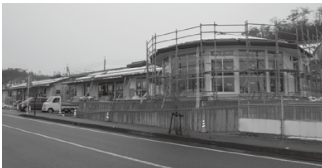
建設中のグループホームみらさか(三良坂町)
