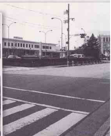
JR三次駅周辺整備
