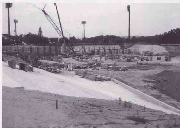
新野球場建設現場(東酒屋町)
