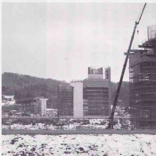
尾道松江線工事風景
