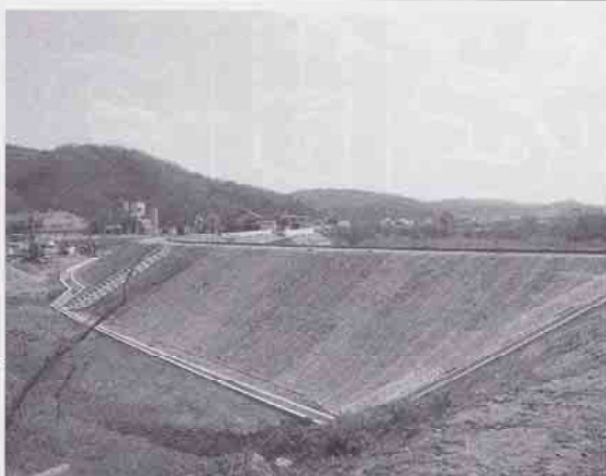
川地地区内の河川改修
