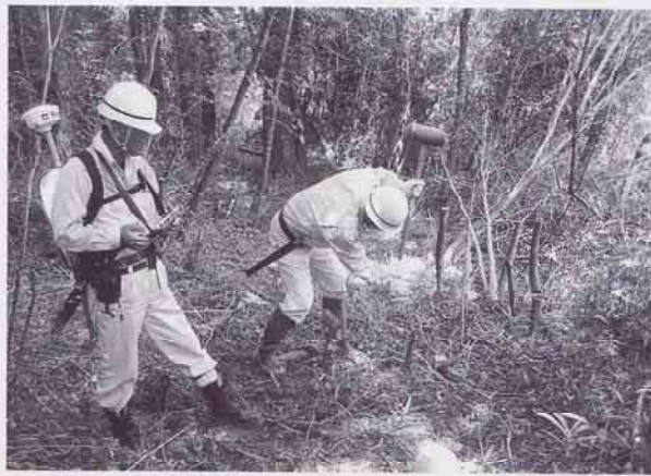
境界点への杭打ち風景
