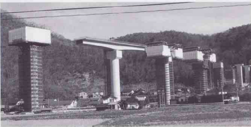
建設中の尾道松江線（吉舎町）
