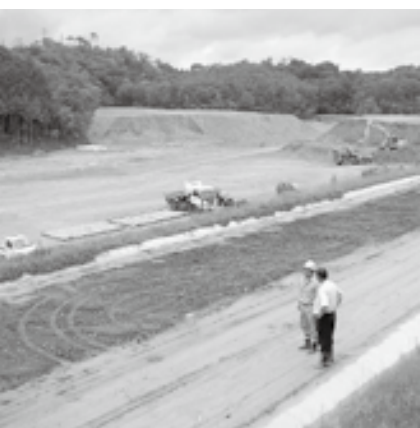
甲奴町の残土処分地
