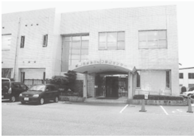
広島北部地域職業訓練センター(三次工業団地内)
