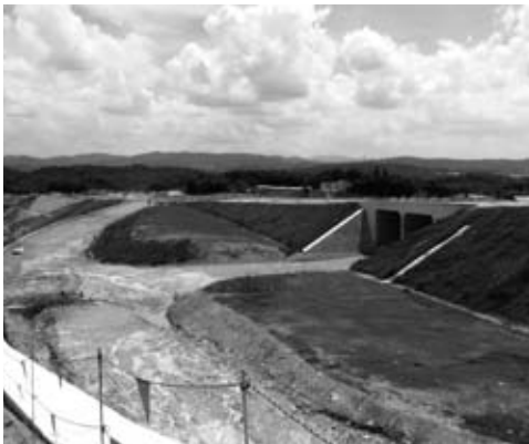
尾道松江線三次 JCT 付近の工事現場
