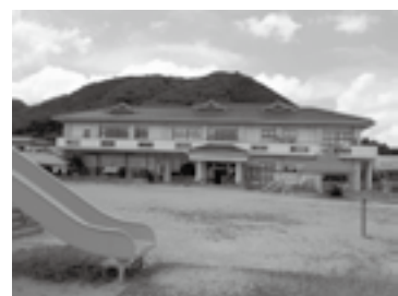
愛光保育所 と見込まれる現在の公設民営の方法を推進している。
