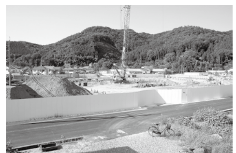
(仮称)三次市民ホール建設現場
