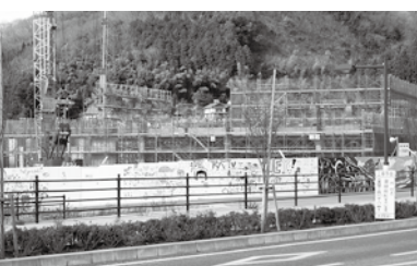
三次市民ホール建設現場
