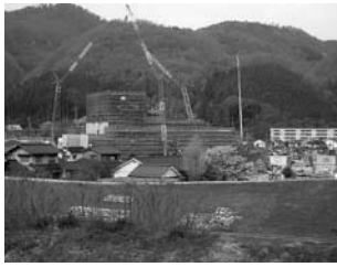
三次市民ホール建設現場
