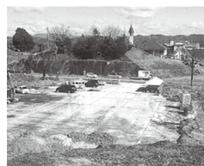
農業交流連携拠点施設建設現場
