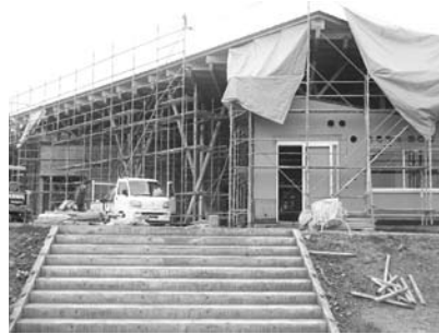
建設中のトレッタみよし
