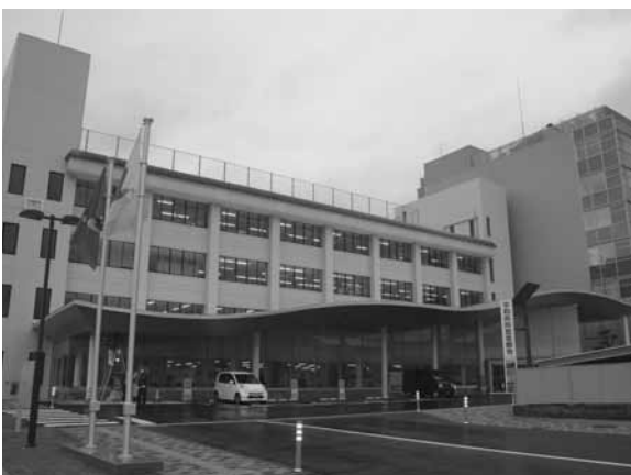
新市役所全景（正面玄関）
