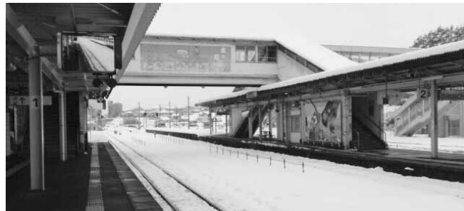
三次駅跨線橋
