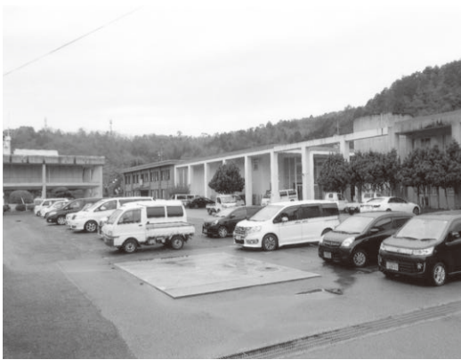
吉舎支所周辺の施設
