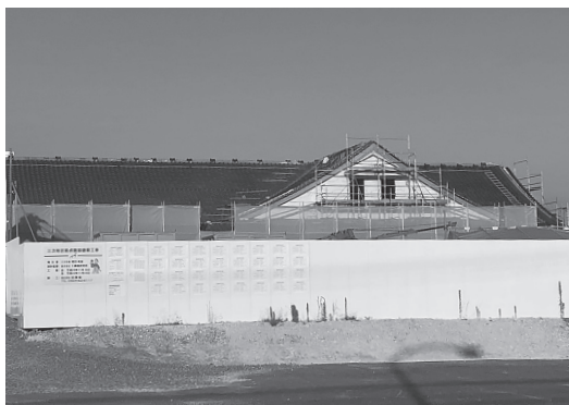
三次地区拠点施設建設現場
