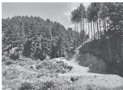
作木町の路網整備
