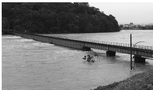
旧三江線鉄橋付近の状況
