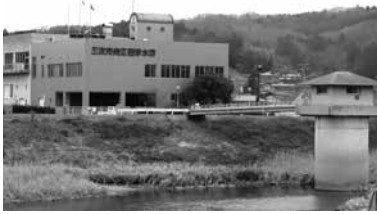
向江田浄水場
