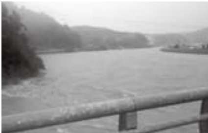
西城川横路橋付近
