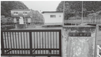
片丘川放水路
