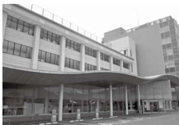
三次市役所本庁舎
