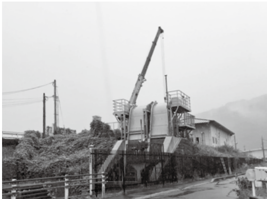
排水機場のポンプが一部停止した
