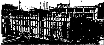
建設中の吉舎町拠点施設
