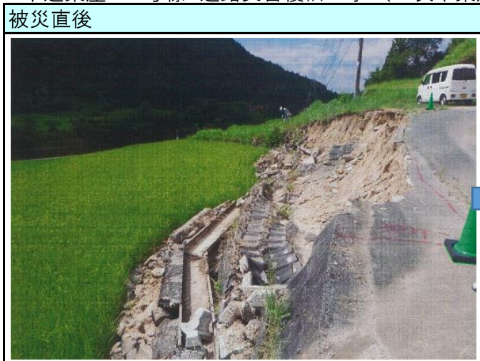
市道粟屋100号線 道路災害復旧工事（三次市粟屋町）
