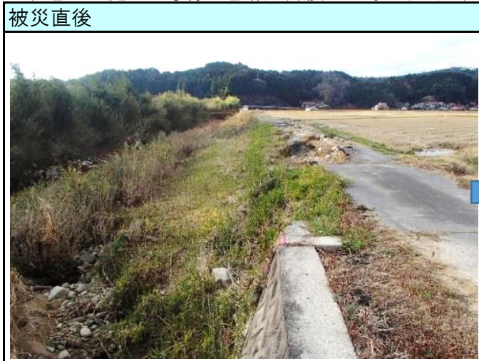
市道羽出庭123号線 道路災害復旧工事（三次市三和町羽出庭）
