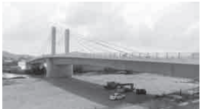
願橋の施工状況(6月15日現在)
