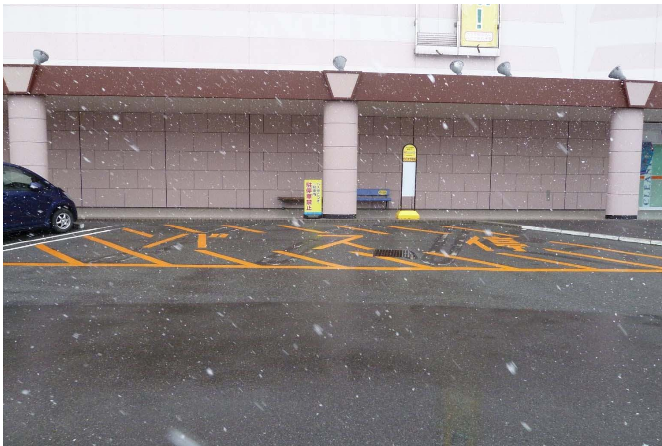
プラザ構内駐車禁止線引き
