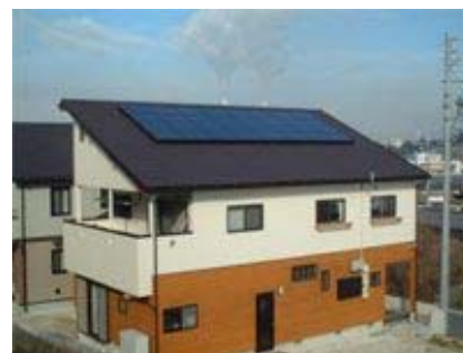
住宅用太陽光発電システム導入例
