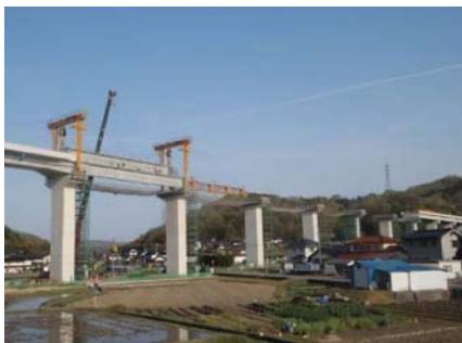
三良坂町 岡田地区の高架橋
